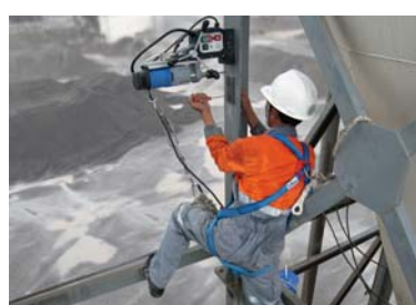
Ein Monteur rüstet ein Silo mit Wägetechnik von DIGI SENS nach.
